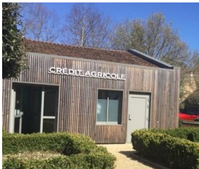
Enseigne parallèle au mur en lettres découpées en SPR, Val de Louyre et Caudeau, mars 2021
