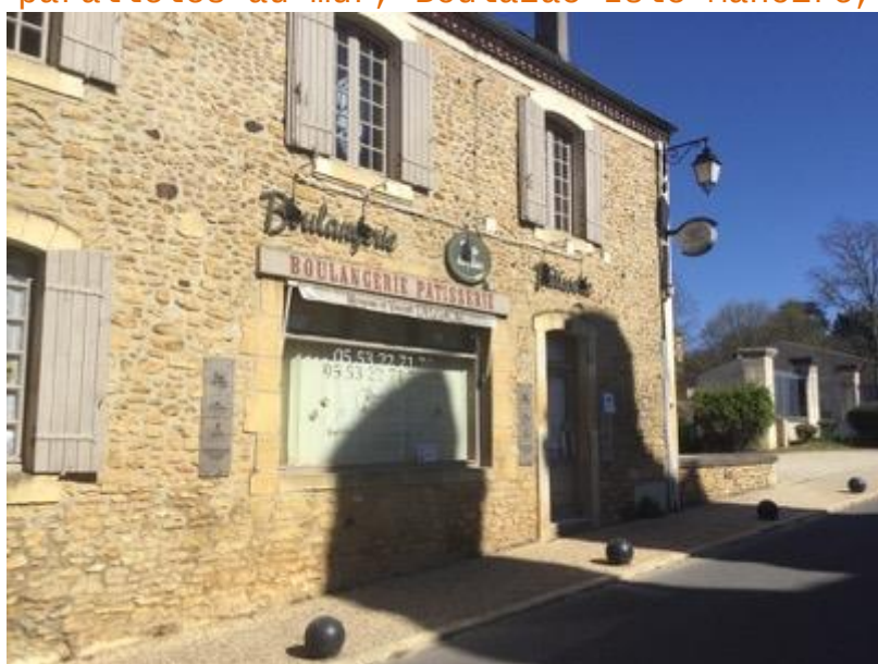
Enseignes parallèles au mur en SPR, Val de Louyre et Caudeau, mars 2021
