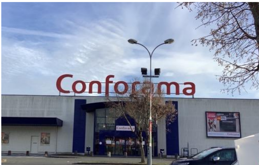
Enseigne sur toiture de grand format (> 50 m 2 ), Boulazac-Isle-Manoire, février 2021
